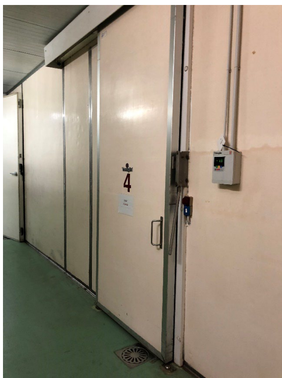
Figura 12 CASA TOSCANA; pannelli in vetroresina
