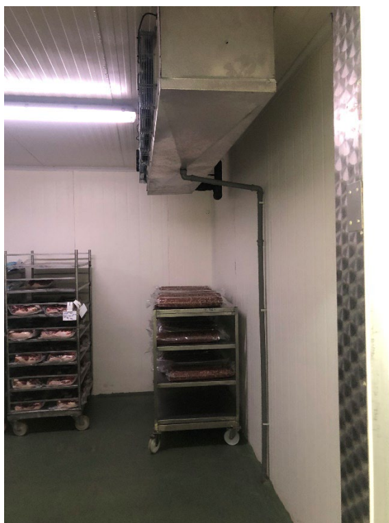
Figura 10 CASA TOSCANA; pannelli in alluminio micronervati
