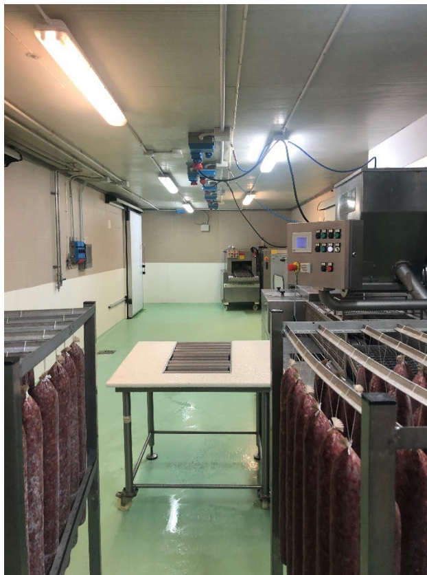
Figura 13 CASA TOSCANA; locale salatura prosciutti, rivestimento in piastrelle
