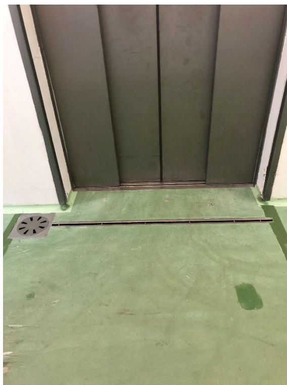
Figura 18 CASA TOSCANA; canalina di scarico
