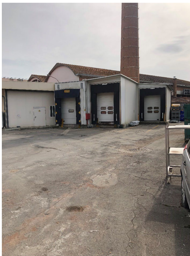
Figura 4 CASA TOSCANA: blocco produttivo ricevimento carni vista dall'esterno
