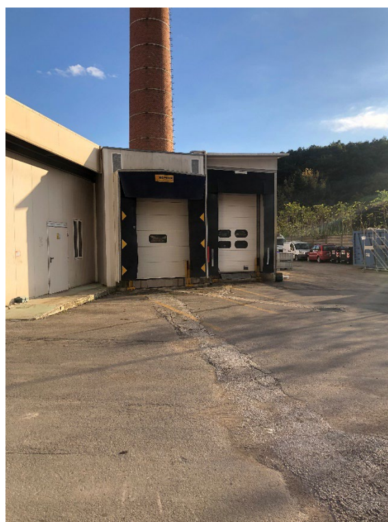
Figura 8 CASA TOSCANA: chiusure esterne baie di carico
