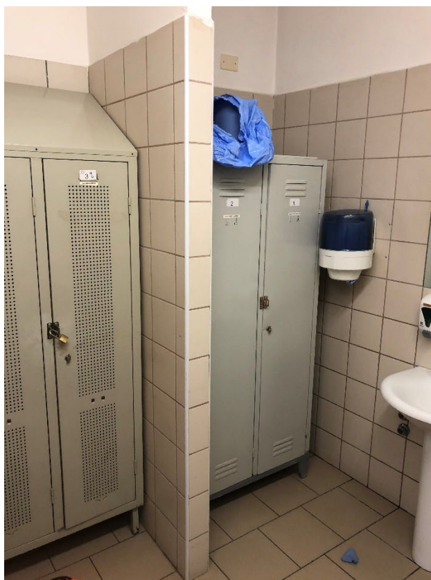
Figura 14 CASA TOSCANA; locali ad uso civili, rivestimento in piastrelle
